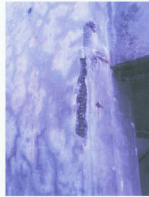
柱・外部コーナー主筋
