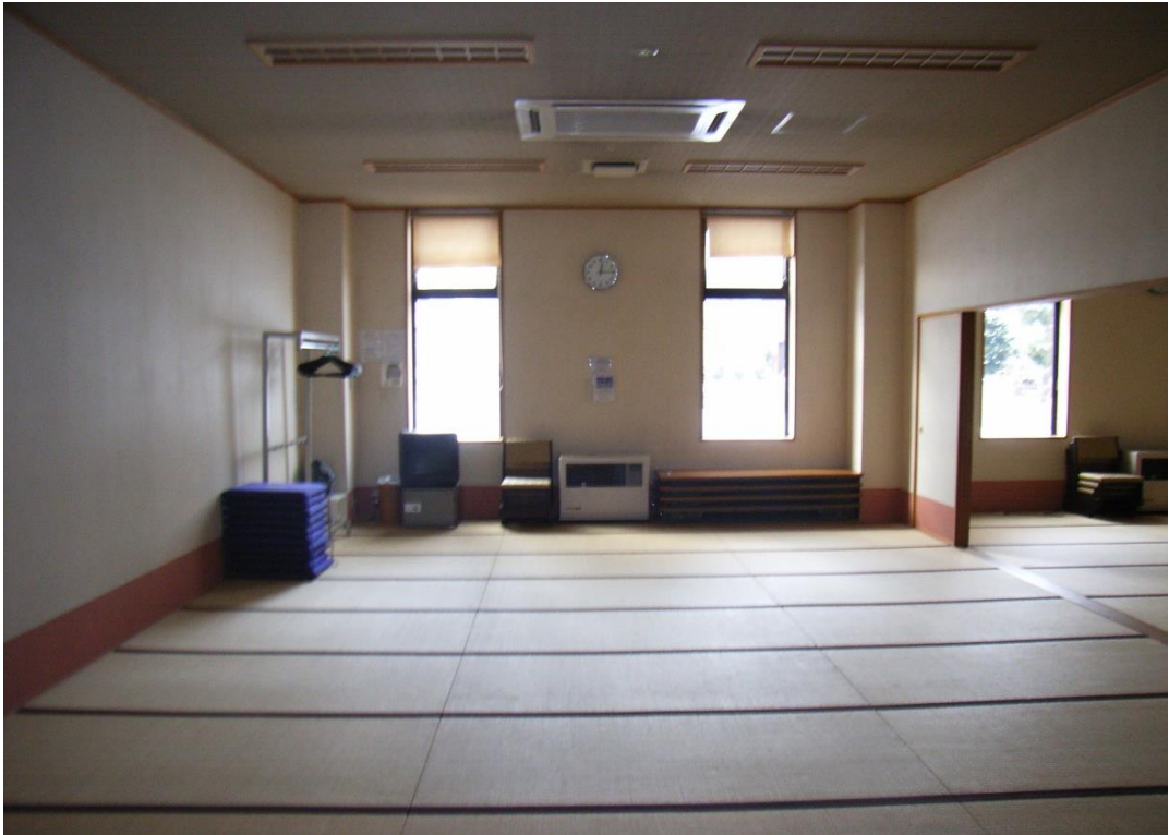
灯油 FF 暖房機設置 1階和室(2)(3)
