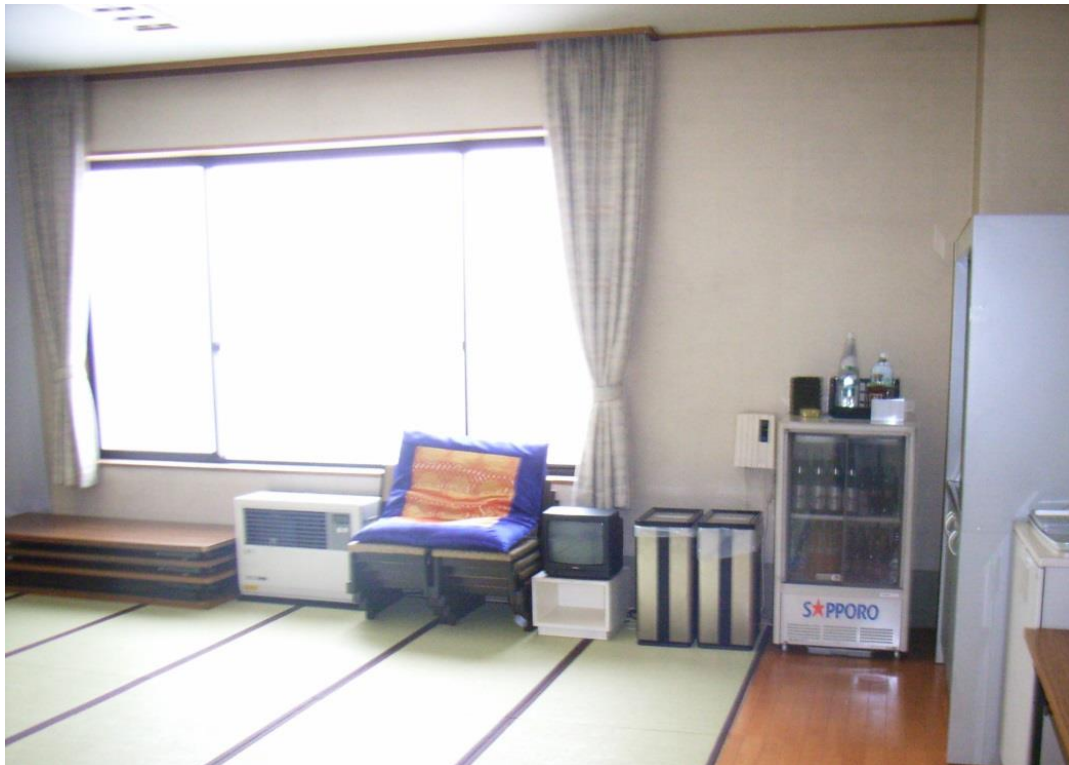
灯油 FF 暖房機設置 2階和室(5)
