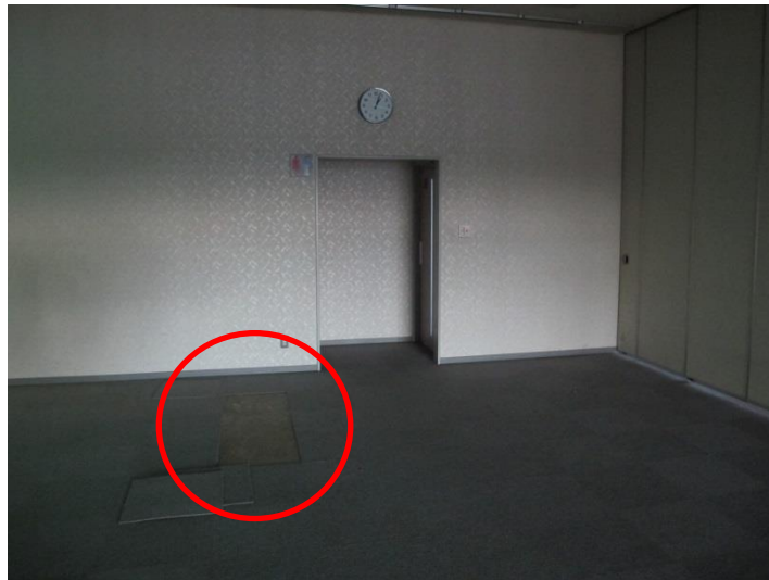
2階ホール 合成スラブ床 (QL デッキプレート床材) 撮影箇所 ③
